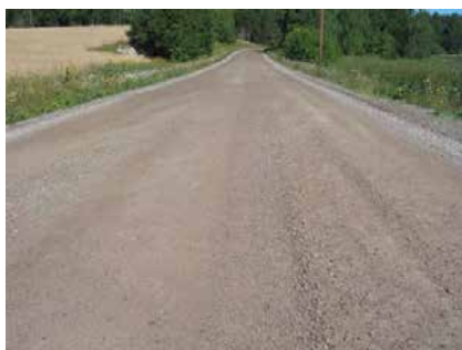
Tillståndsvärde 2. Löst grus förekommer i mindre omfattning på vägbanan och i mindre vallar längs vägkanterna, vilket inte inverkar på körkomforten och säkerheten i någon högre grad.
