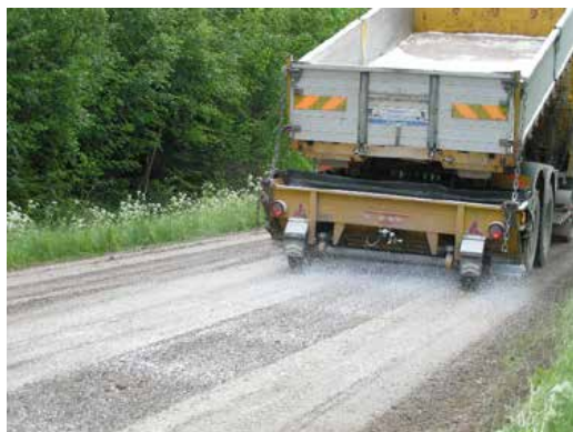
En grusväg som dammbinds med kalciumklorid. Foto: Karin Edvardsson.
