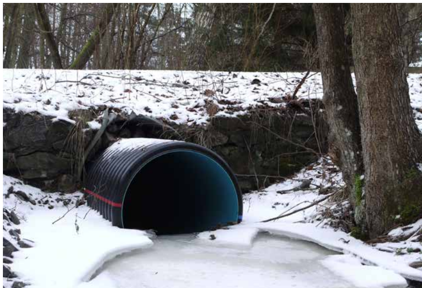
Infodring, s.k. relining, av vägtrumma. Fotografi till Riksförbundet Enskilda Vägar/Leif Kronkvist.
