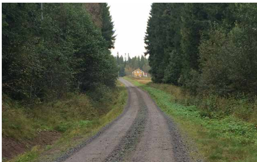
Exempel på väl utförd sidoröjning. Foto: Ulrika Appelberg.
