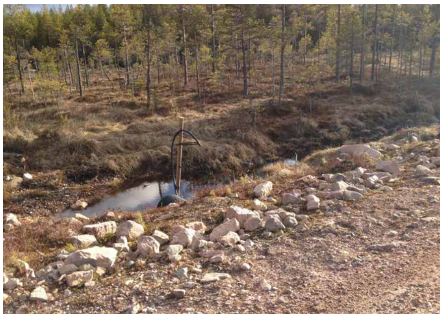
En vägtrumma där man har förberett inför trumtining genom att "montera in" en slang, som man sedan hängt upp på en "pinne". Foto Karin Edvardsson.
