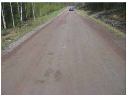
Tillståndsvärde 1. Löst grus på vägbanan förekommer inte alls eller endast i ringa omfattning längs vägen.
