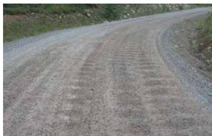
Tillståndsvärde 4. Stora delar av vägbanan är ojämn på grund av potthål och korrugeringar. Föraren måste oavbrutet ändra och anpassa sin körhastighet efter ytans tillstånd.
